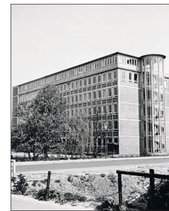
Die VHS wurde 1957/58 als Berufsschule gebaut.
